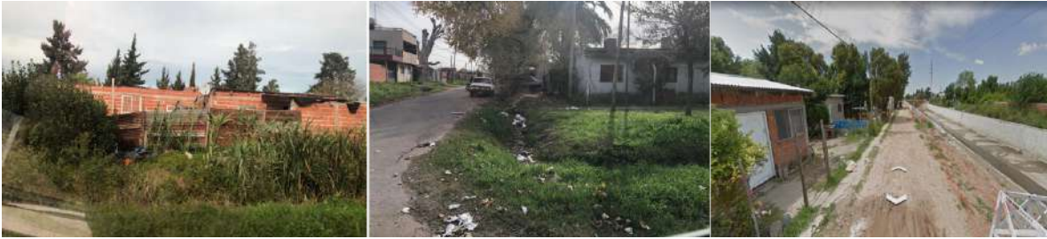
Imagen 4. Situación actual del barrio La Granja.
