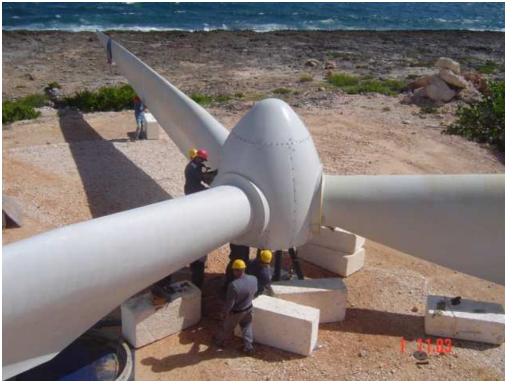
Foto 1: Instalación de un aerogenerador de Gibara I. Fuente: Grupo de Trabajo para el Impulso de la Energía Eólica
